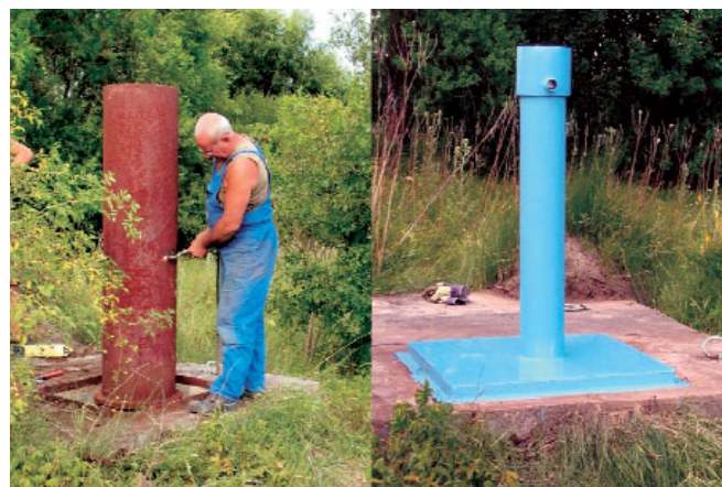
Zsámbék – 13, régi kútfej felújítása (balra); új, egységes kútfej (jobbra)
